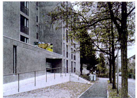
2 Der Versatz als architektonisches Thema: Gegen den Hof öffnen sich grosszügige Balkone – die vorgefertigten geschosshohen Platten wirken durchlässig.
